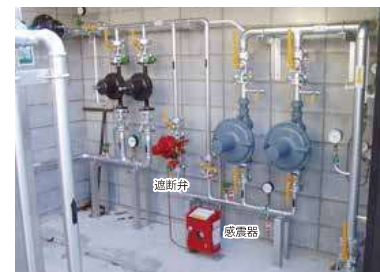
感震自動ガス遮断装置
